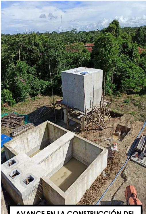
**AVANCE EN LA CONSTRUCCIÓN DEL RESERVOIRIO 30 M3 Y FILTRO LENTO**
