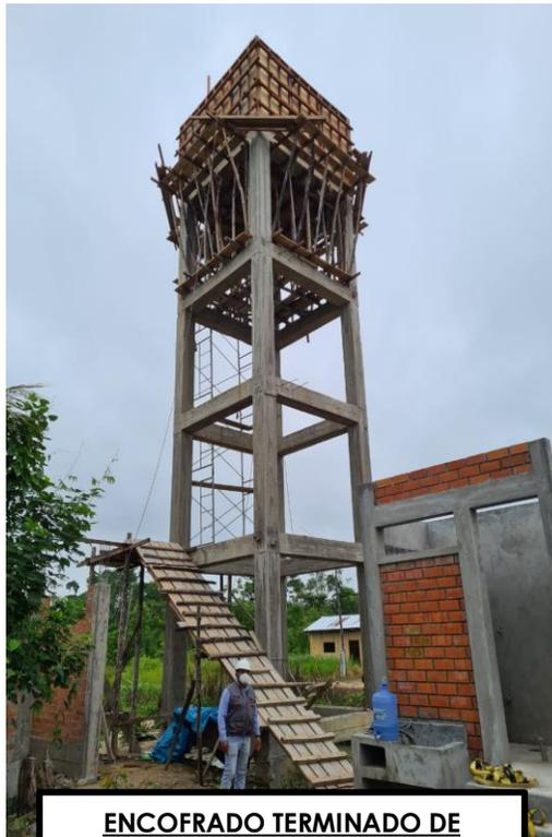
**ENCOFRADO TERMINADO DE TANQUE ELEVADO 22 M3**
